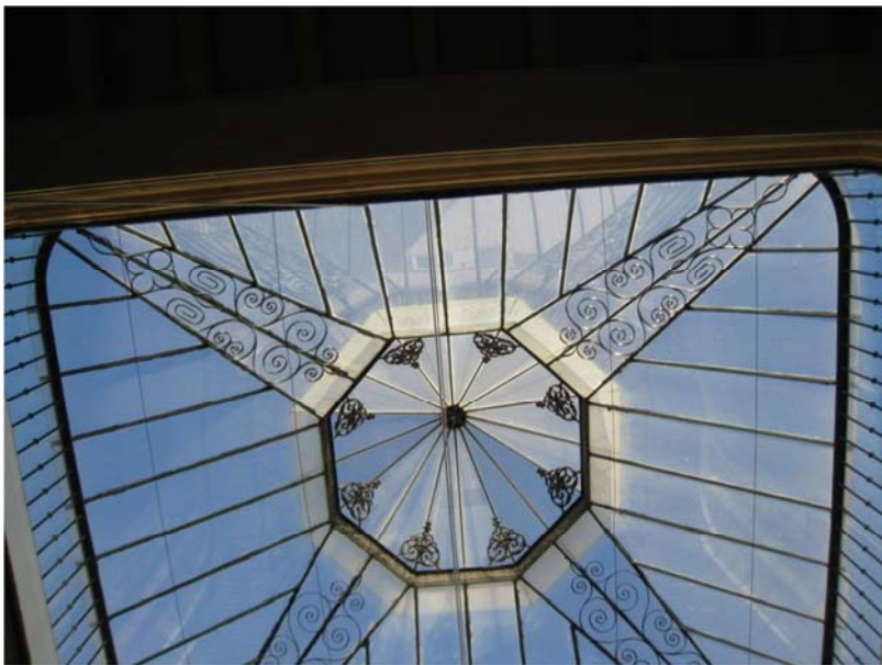
Enmasillado y pintado de montera del patio central.
