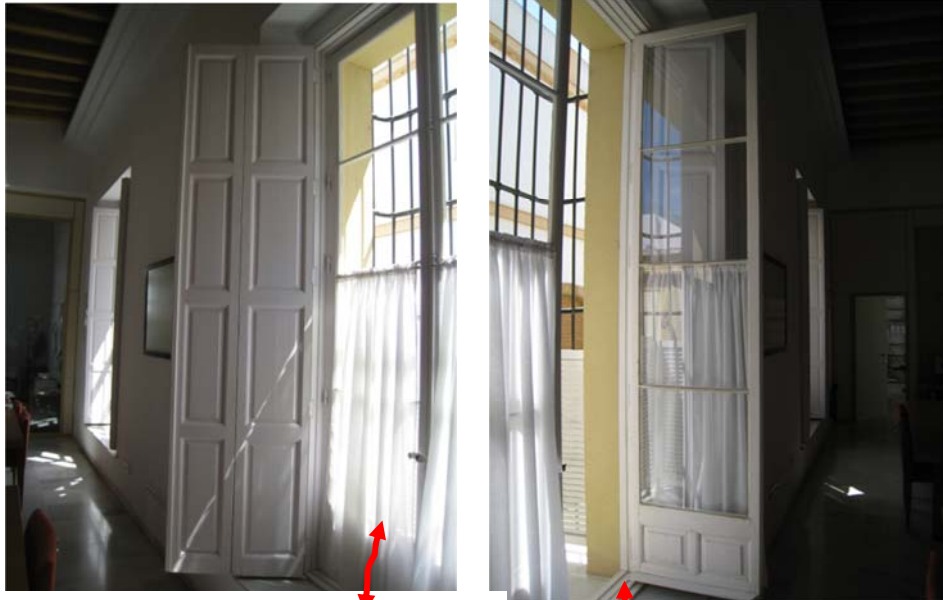
Sustitución de ventanas con tapaluces.
