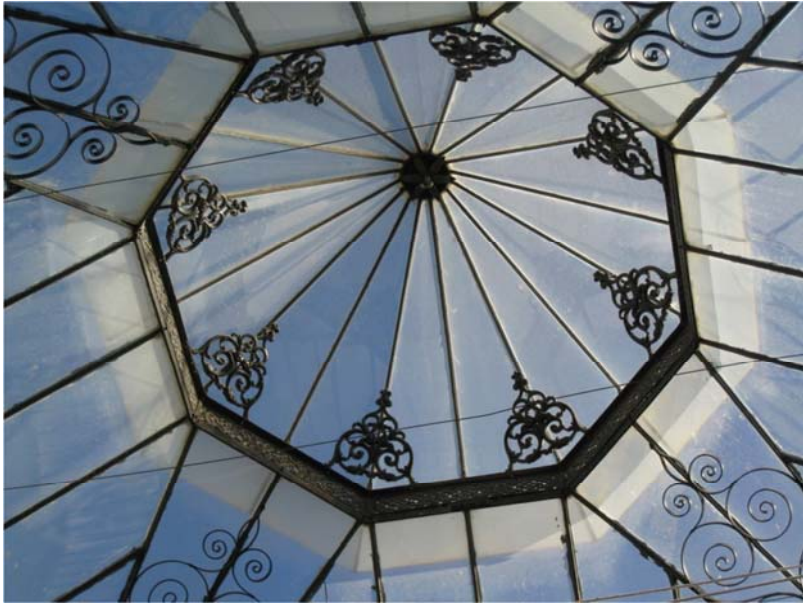
Enmasillado y pintado de montera del patio central.
