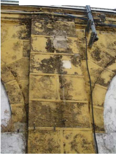
DETALLE DE PILASTRA Y HOMBROS DE LOS ARCOS.
